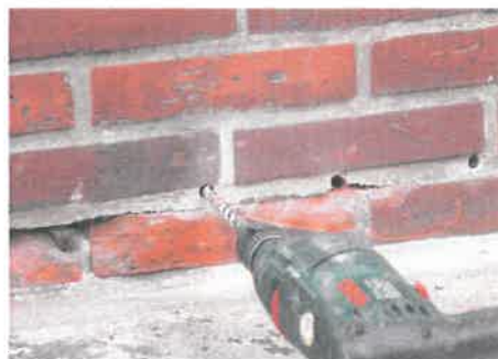
Der Feuchtigkeit den Weg versperren: Die „Intrasit IC 280S“, eine auf Silanbasis hergestellte Injektionscreme, verspricht selbst bei stark durchfeuchteten Wänden eine perfekte Abdichtung. Das Besondere: Anders als bei flüssigen Materialien entsteht hier dank der cremigen und daher standfesten Konsistenz kein unkontrolliertes Abfließen innerhalb der Wand. Hahne/epr
