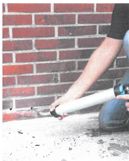
Der Feuchtigkeit den Weg versperren: Die „Intrasit IC 280S“, eine auf Silanbasis hergestellte Injektionscreme, verspricht selbst bei stark durchfeuchteten Wänden eine perfekte Abdichtung. Das Besondere: Anders als bei flüssigen Materialien entsteht hier dank der cremigen und daher standfesten Konsistenz kein unkontrolliertes Abfließen innerhalb der Wand. Hahne/epr
