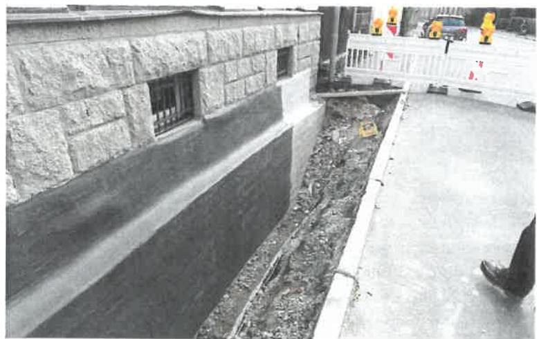
Die Abdichtung des Sockels erfolgte mit „Multi Baudicht 2K“. Darauf kam ein Anfüllschutz- und Dränelement.
