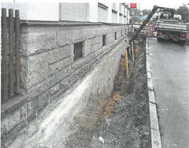
Um den Sockelbereich für die Zukunft fit zu bekommen, musste tief abgegraben und viel Erde bewegt werden.
